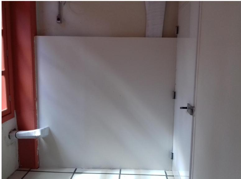
Gesso acartonado RU, instalado na sala de monitoramento do datacenter.
