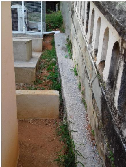
Fotos do embutimento da tubulação do ar condicionado
