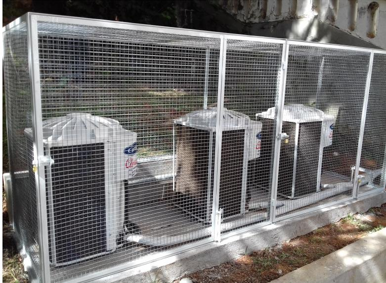
"Gaiola" para as condensadores, instaladas à frente do novo Datacenter.
